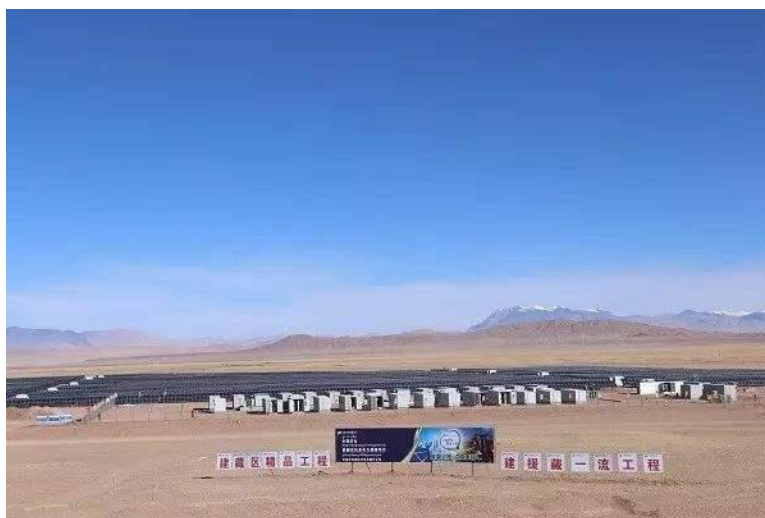
图 1 光储电站实物图
